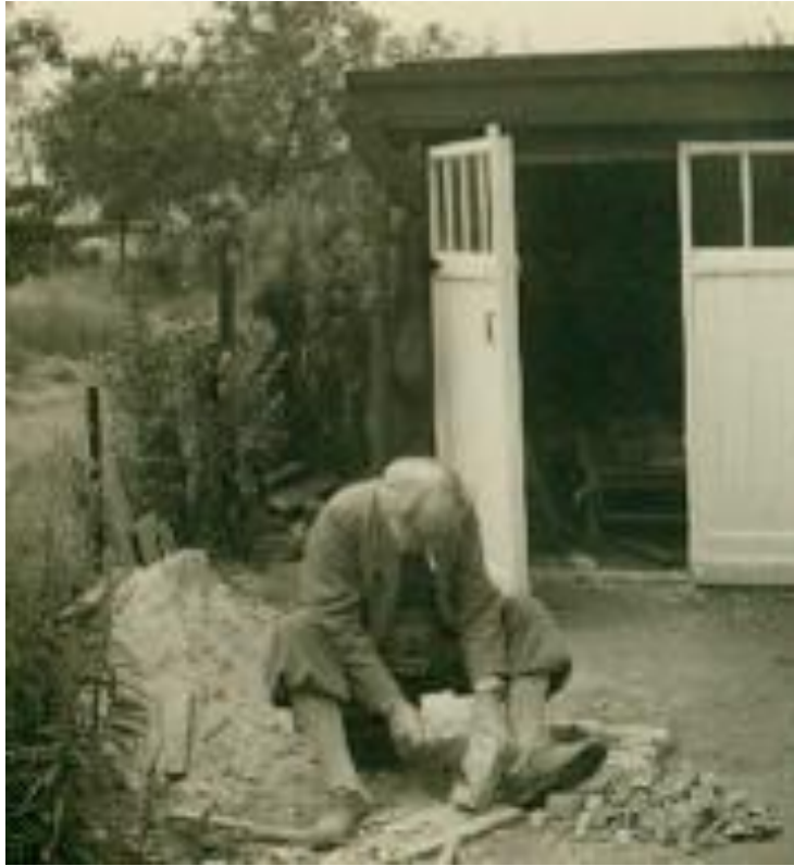
Lode van der Linden beim Bau des Landhauses in Ranst bei Antwerpen, Anfang der 1950 Jahre Das Landhaus war ursprünglich eine gemauerte „Zelle“ für Gartengeräte. In eigener Hände Arbeit baute Lode van der Linden zusammen mit einem Gärtnergehilfen diese aus. Es wurde ein flämisches Häuschen. Nach ca. 2 Jahren kamen nach und nach auf beiden Schmalseiten halbrunde bzw. polygonale Pergolen daran (gegossene Betonstützen mit Glasscheiben dazwischen). Lode van der Linden war auch Architekt. Er hatte enorme Muskelkräfte. Die Einrichtung wurde liebevoll auf Antik- und Flohmärkten zusammengetragen und laufend phantasievoll ergänzt. (Album Erika Schmelter, Alfter)
